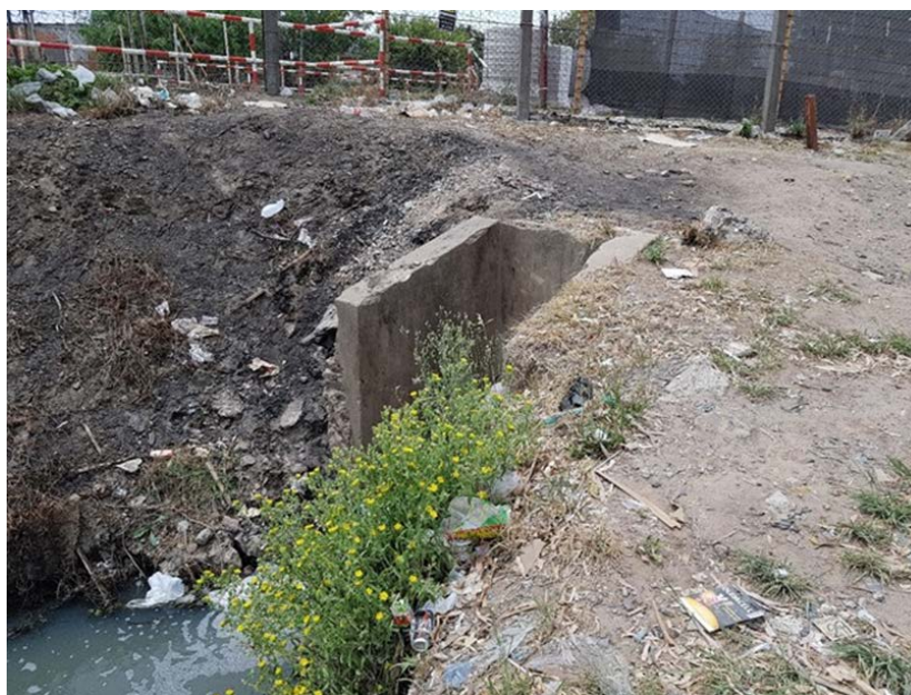
Fotos 2 y 3. Vistas del zanjón
